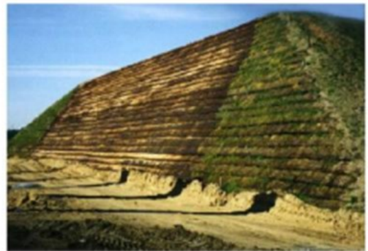
मातीच्या भरावाचे मजबुतीकरण (Reinforced Soil Slope)
